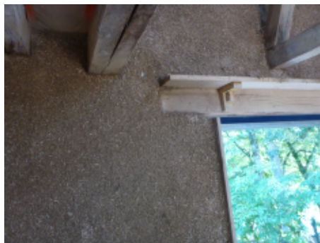
Isolation par l'intérieur 8 - 10 cm d'une grange du Loir et Cher
