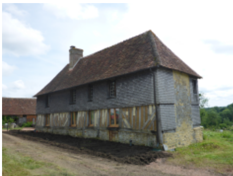
Isolation d'une maison en pan de bois du Pays d'Auge (mur et planchers)
