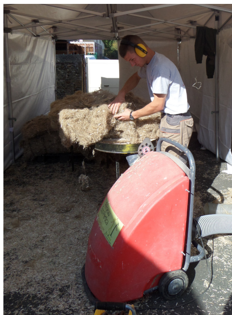
Chantier Éco-Pertica à Bretoncelles, insufflation de laine de chanvre
