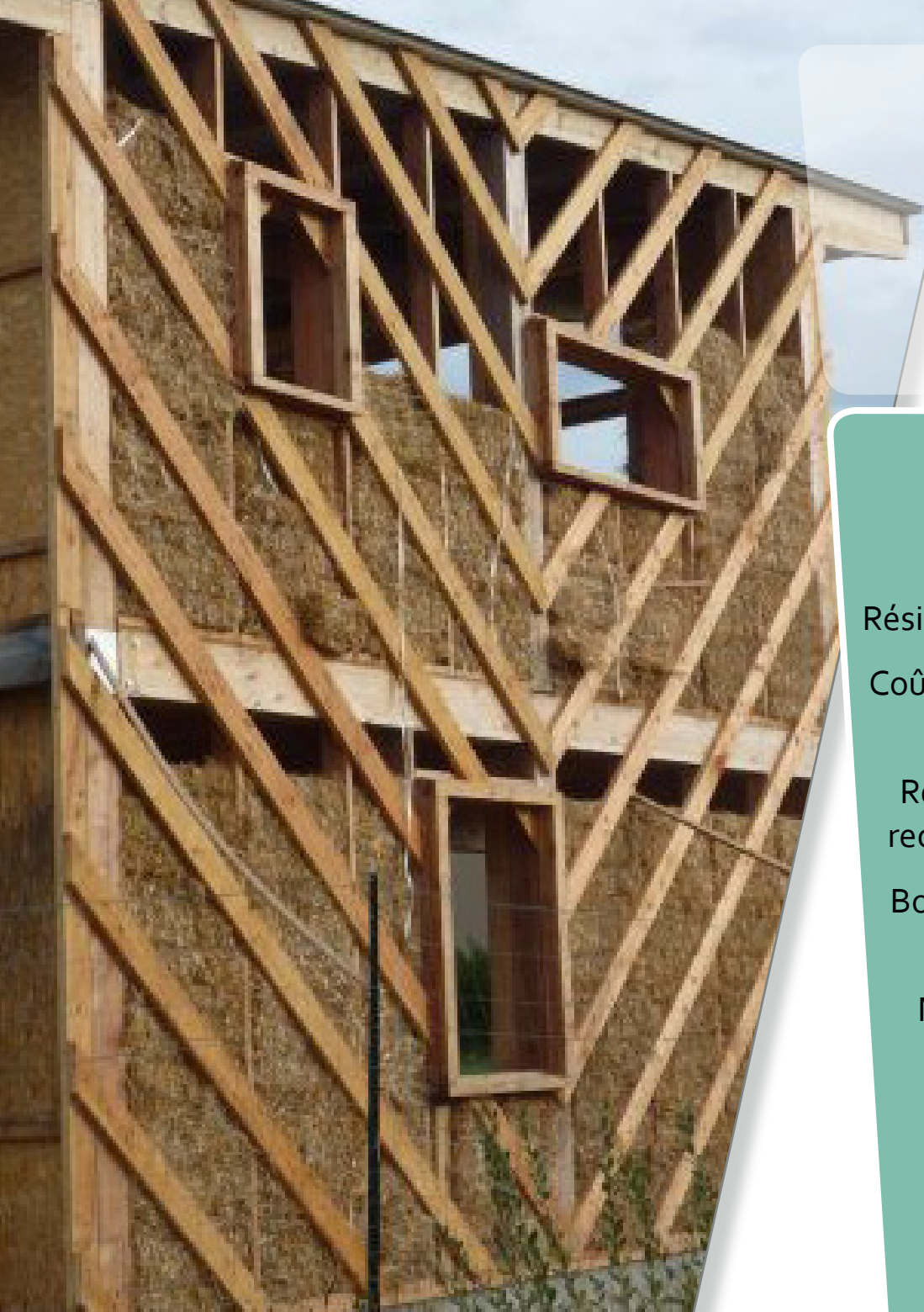
Les Z'écobâtitseurs, Louvigny
