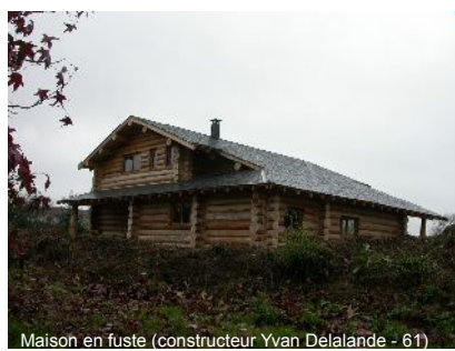
Maison en fuste (constructeur Yvan Delalande - 61)
