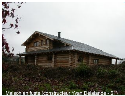
Maison en fuste (constructeur Yvan Delalande - 61)
